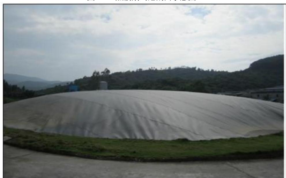
图3.1-10建成后的黑膜沼气池示意图
