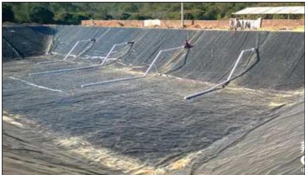
图3.1-8黑膜沼气池内部示意图
