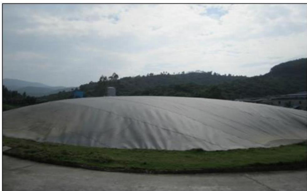
图3. 1-10建成后的黑膜沼气池示意图
