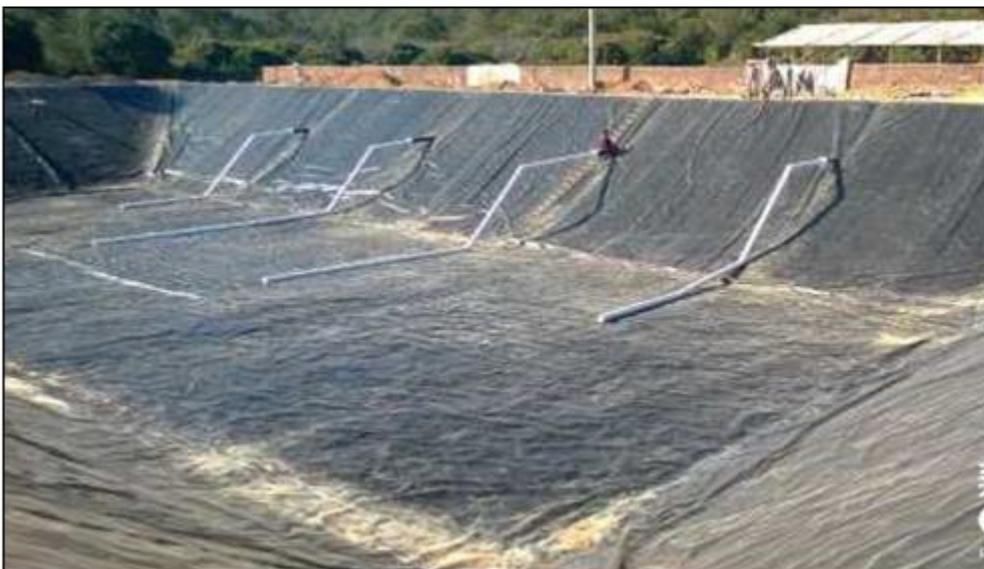
图3. 1-8黑膜沼气池内部示意图
